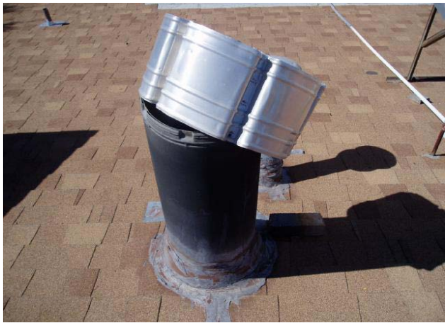
Loose Chimney Cap
