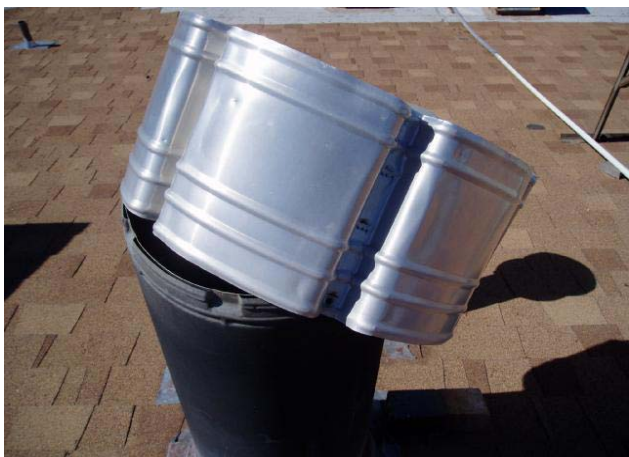
Loose Chimney Cap
